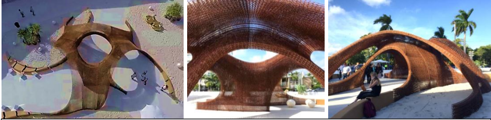
شكل (٥) تصميم مظلة طباعة شركة Branch Technology في ميامي بالولايات المتحدة الأمريكية. مصنوعة من مركب
