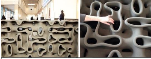
شكل (٤٣) القاطوع الرملي من تصميم وطباعة Emerging Objects لتقليل الرنين في القاعات الموسيقية .
